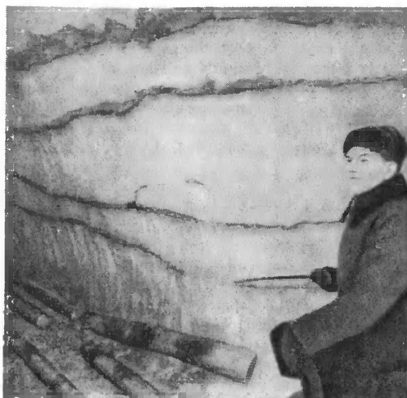
Рис. 3. Следы опилочной теплоизоляции в ледяных стенах склада
